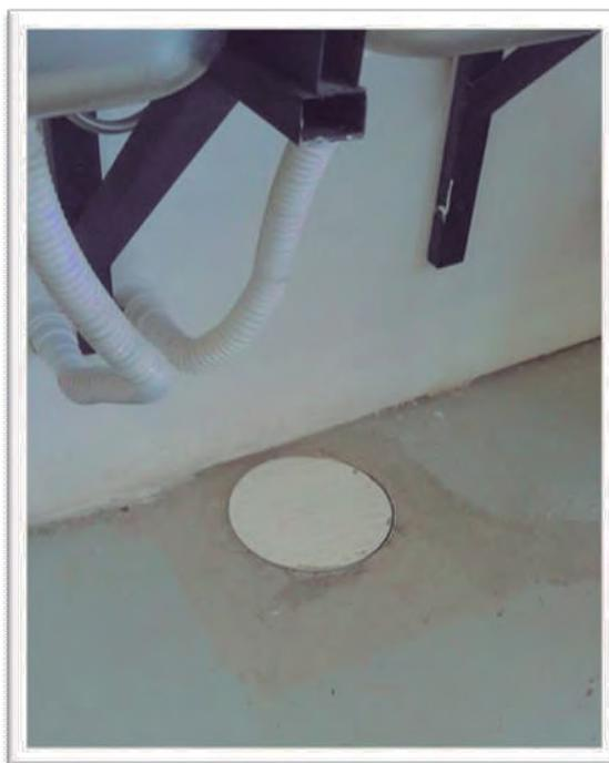
Fig. 35 – Caixa de gordura interna e ausência de sifão
